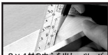
2×4材の中心を出し、ツーバイフォー工法による間柱455mmピッチの中心出しを行います。
